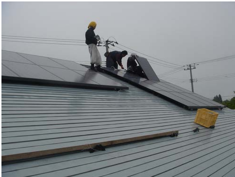
Instalando paneles solares en un techo.
